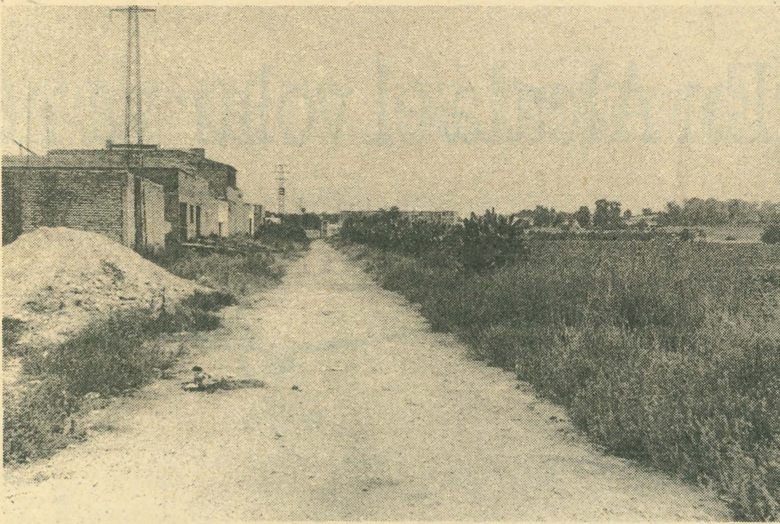
La línea férrea Sevilla-Cármona.
