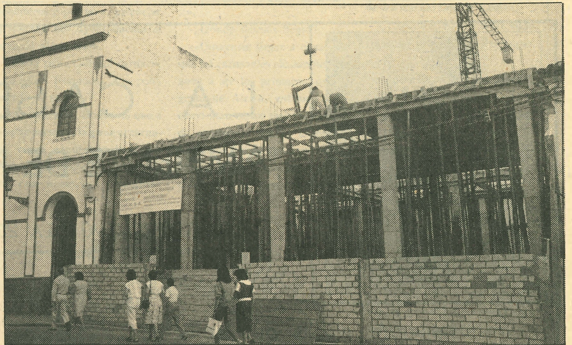
37 millones, presupuesto de la primera fase de las obras de ampliación del Ayuntamiento
