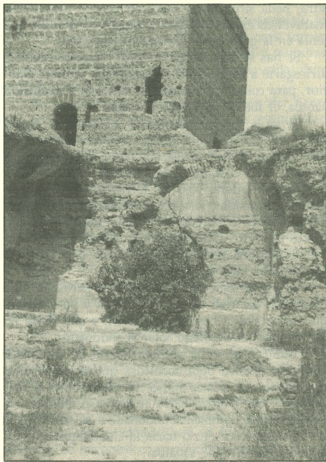
N.º 16. Ruinas del alljibe y su escalera.
