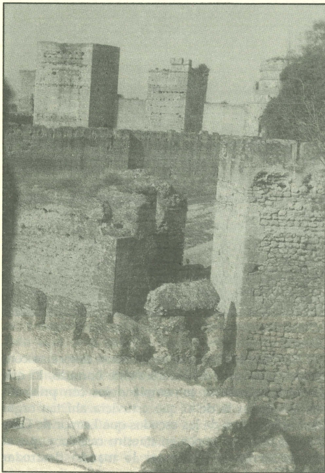
N.º 18. Restos de la Puerta del Arrabal.
