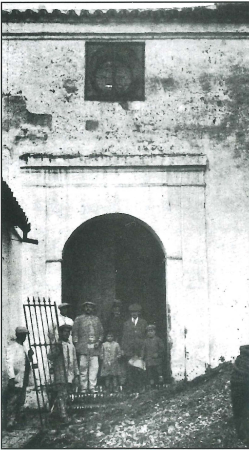
Portada original de la primitiva capilla que edificaron los carmelitas al trasladarse a casco urbano en 1582. Hoy es capilla del Santo Entierro.
