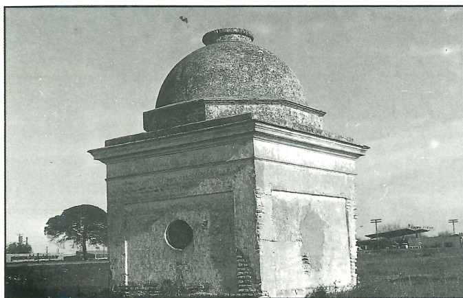
Caja Registro del XVII, derribada en 1989, pese a estar catalogada por ser el último recuerdo del acueducto Alcalá-Sevilla.
