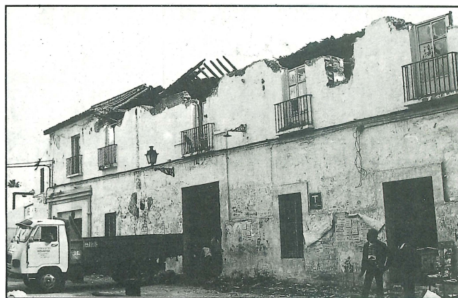
Derribo de casa solariega en pleno centro de Alcalá, por los años sesenta.
