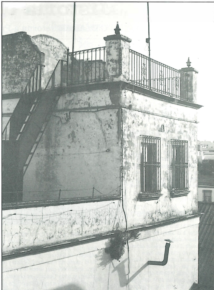
Perspectiva de la casa, con el mirador en forma de sillón.
