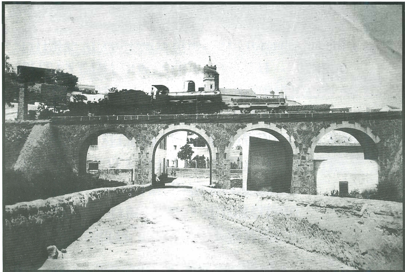
El viejo Puente con pretiles, hechos de tapial y a pisotón, nos recuerda su fisonomía medieval. En la parte superior el conocido Puente del Ferrocarril construido hacia 1870, que transformó agradablemente dicho entorno.
