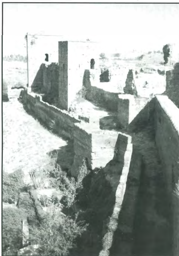
Estado actual del flanco suroeste del alcázar.
