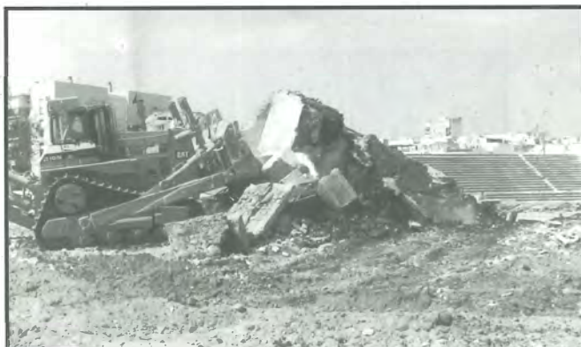
El 25 de marzo del presente año comenzó el derribo de la Plaza de Toros de Alcalá de Guadaíra, con una celeridad en las tareas que asombraron a muchos.
