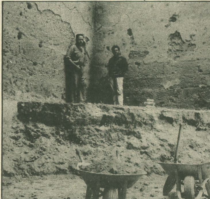
Abril de 1965. Se está terminando el desescombro de la torre entre patios.
