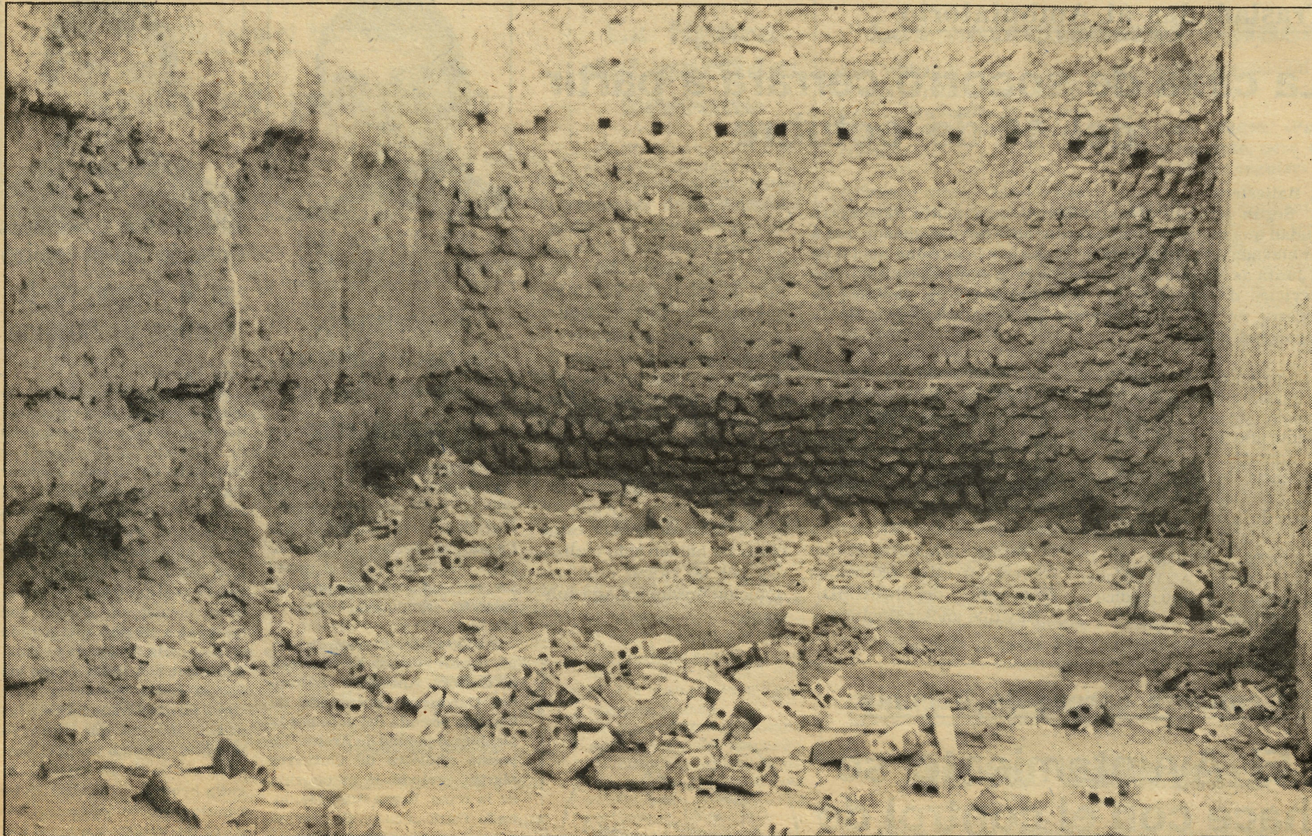
Este fue el lugar que se destinó al servicio de caballeros con motivo de la celebración de los terceros festivales «Castillo de Alcalá». La edificación, como muestra la foto de Fernando Trigo, se apoyó sin ningún sonrojo sobre los muros del castillo en los que aún quedán rastros del yeso que fue utilizado para unir los ladrillos a la centenaria pared. Los escombros producto de la demolición o el gamberrismo están amontonados de cualquier manera donde antes estuvieron cumpliendo su función.
