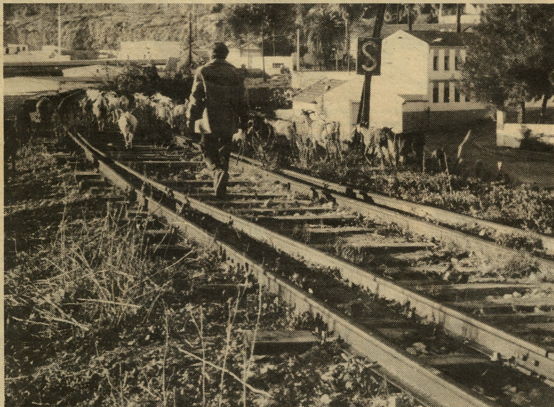
ALCALÁ SE QUEDA SIN TREN: Una vez abandonado definitivamente la construcción del metro sevillano, el proyecto de unir Alcalá a la red del metropolitano con un tren de cercanías parece también condenado al olvido. Las vías del tren alcalaño abandonadas. Todo un símbolo de otra esperanza imposible para Alcalá. Foto G. Cordero
