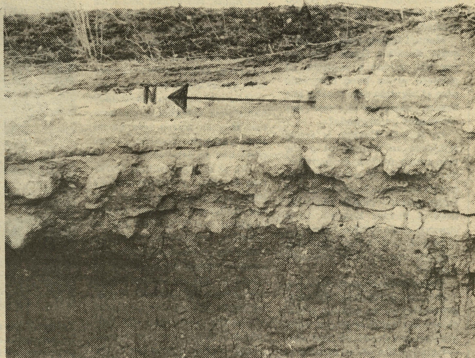
Perfil del camino de La Aceña que atraviesa el yacimiento, en el que se aprecian los diferentes estratos de piedras y tierra.
