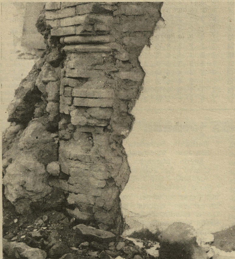
Este pilar o columna, que todavía conserva los detalles de su ornamentación, debía servir de punto de arranque de un arco mudéjar. Estaba escondido entre dos tabiques y muchas capas de cal.
