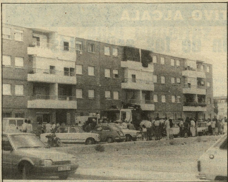
Los vecinos, desalojaban sus casas mientras el bloque de pisos amenazaba con derrumbarse. Foto F. TRIGO.
