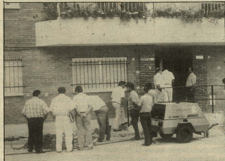
Emasesa realizó prospecciones para ver si el agua fue el causante del movimiento del edificio. Esta posibilidad ha quedado desechada. Foto: G. CORDERO.
