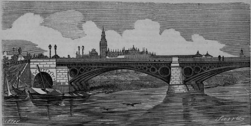
Puente de hierro de Sevilla.
