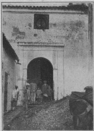
Portada de la Capilla, antes de su restauración y separación de la Iglesia del Carmen
