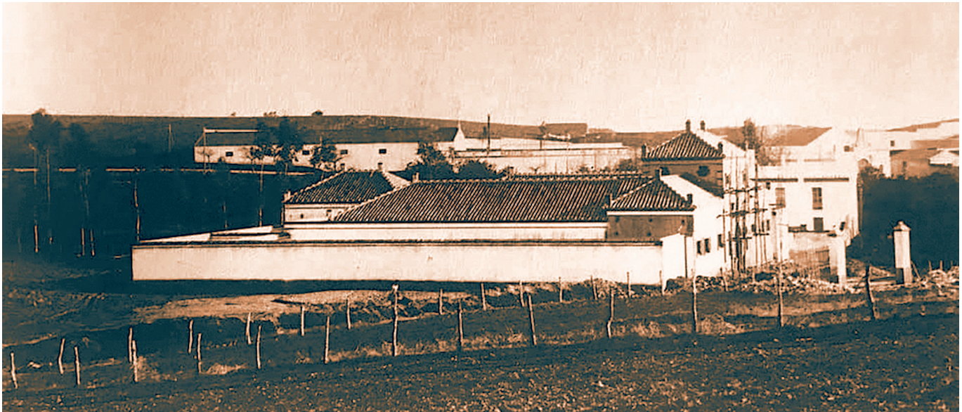
Obras de construcción del Matadero Municipal (1927)
